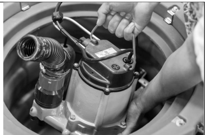
Con un destornillador Philips, saque el tornillo de sujeción de la tapa de la entrada de la bomba y retire la placa de la base de la bomba. Limpie todos los desechos del área de entrada. Vuelva a colocar la placa cuando termine.
