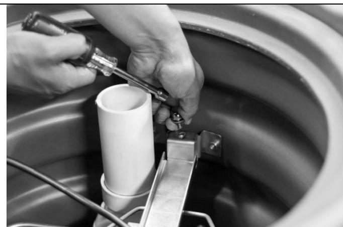
Inspeccione el montaje del flotador. Verifique el flotador, el eje del flotador y el brazo del interruptor del flotador para verificar que funcionan sin problema. Limpie si es necesario.
